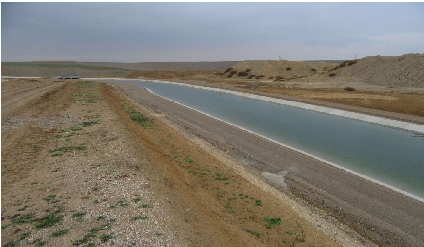
نمایی از کانال بعد از آب‌اندازی جهت بهره‌برداری آزمایشی (قبل از تحویل موقت)
