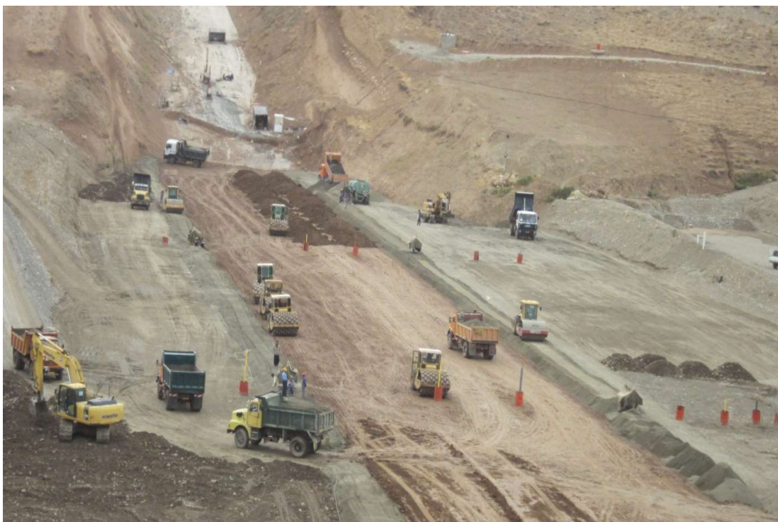
عملیات خاکریزی بدنه سد
