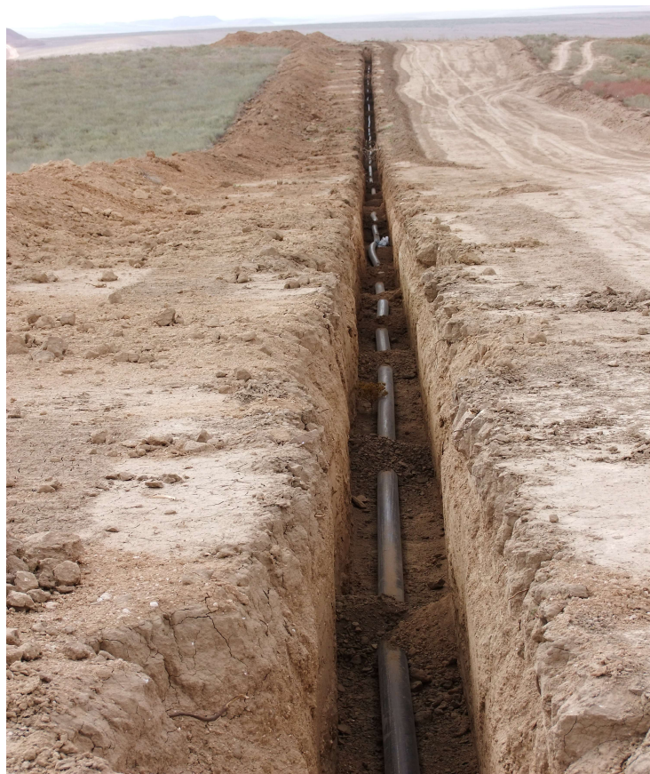
نمایی از مسیر لوله‌گذاری با لوله پلی اتیلن
