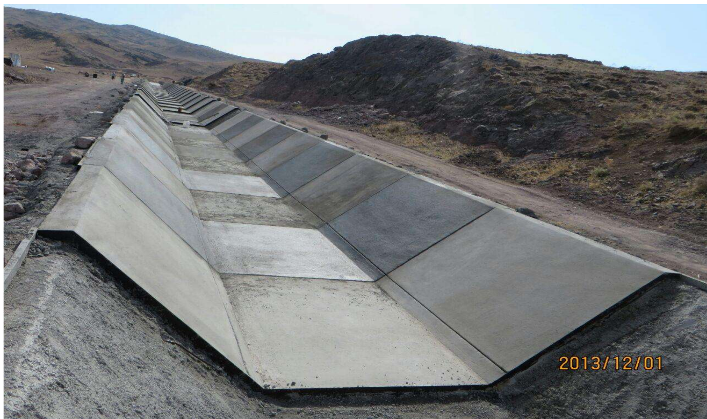
نمایی از اجرای کانال دوزنقه‌ای با پوشش بتنی
