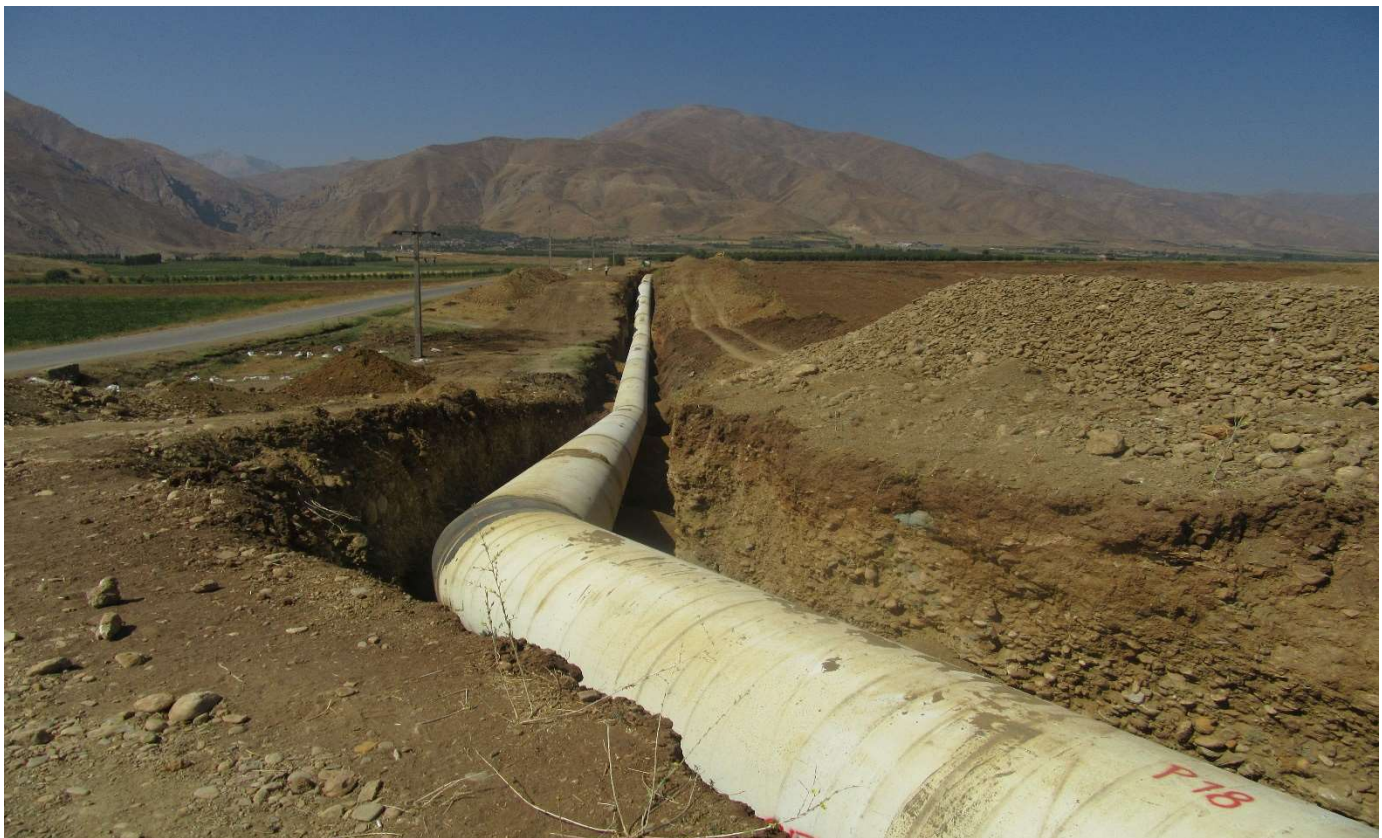
اجرای عملیات لوله‌گذاری فولادی
