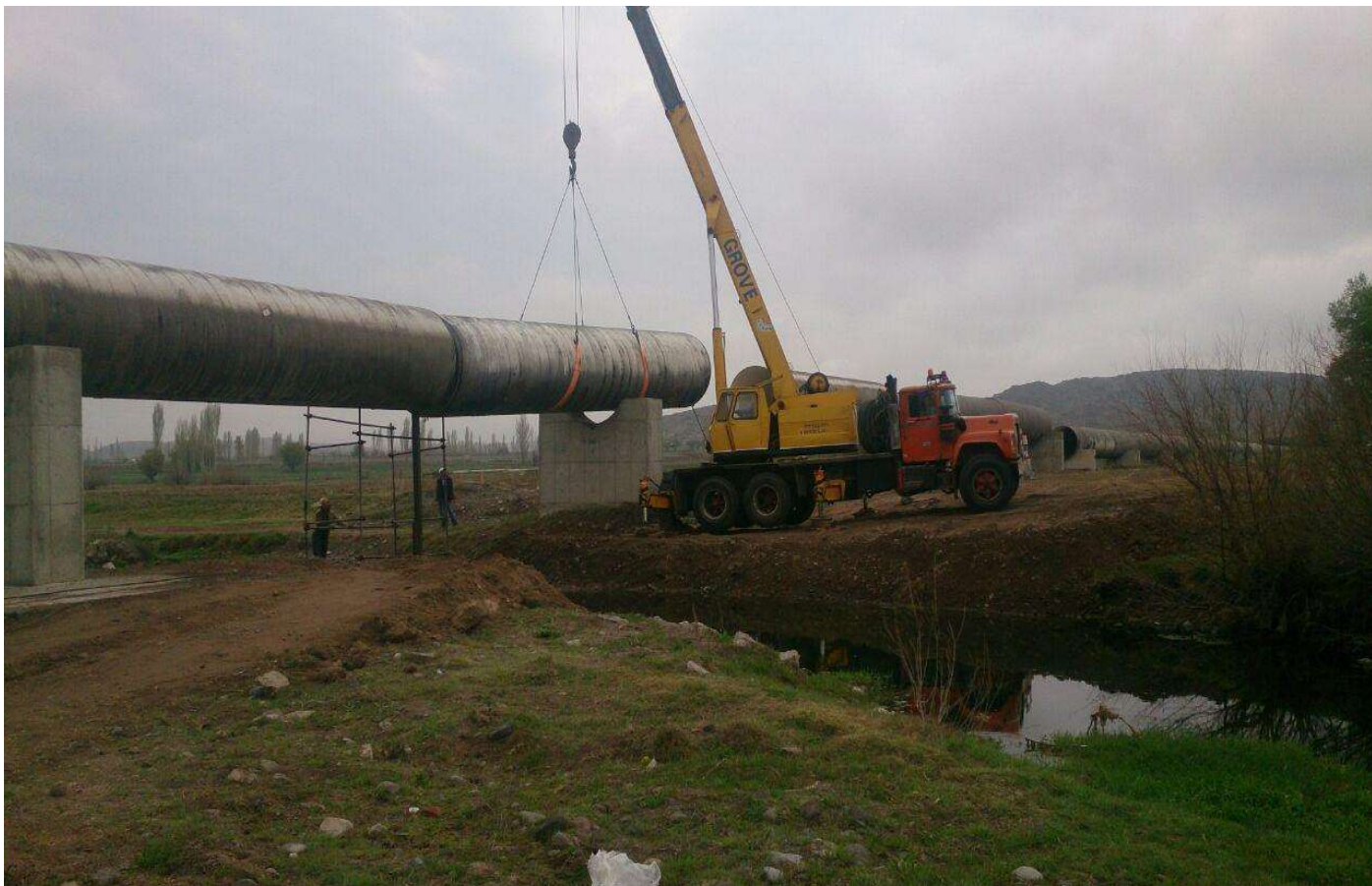
نمایی از لوله‌گذاری با لوله فولادی به قطر ۲۰۰۰ میلی‌متر روی پایه‌های بتنی در رودخانه قره‌سو
