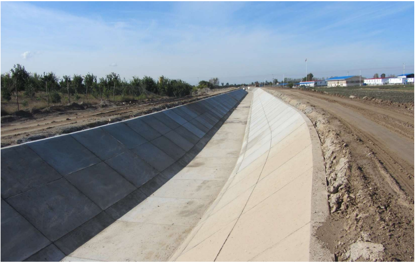
نمایی از کانال و محل تجهیز کارگاه
