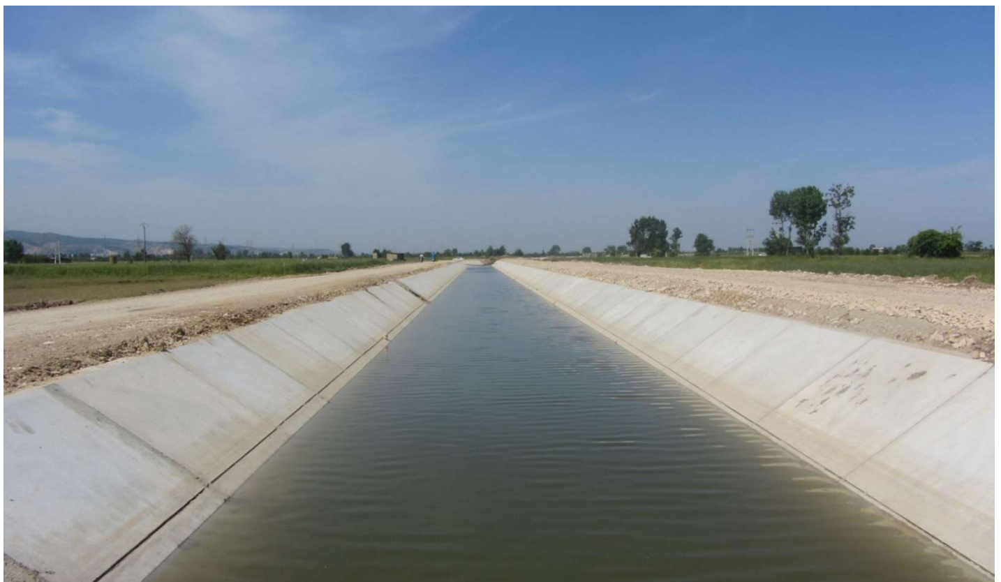
نمایی از آباندازی کانال BMC جهت بهره‌برداری آزمایشی
