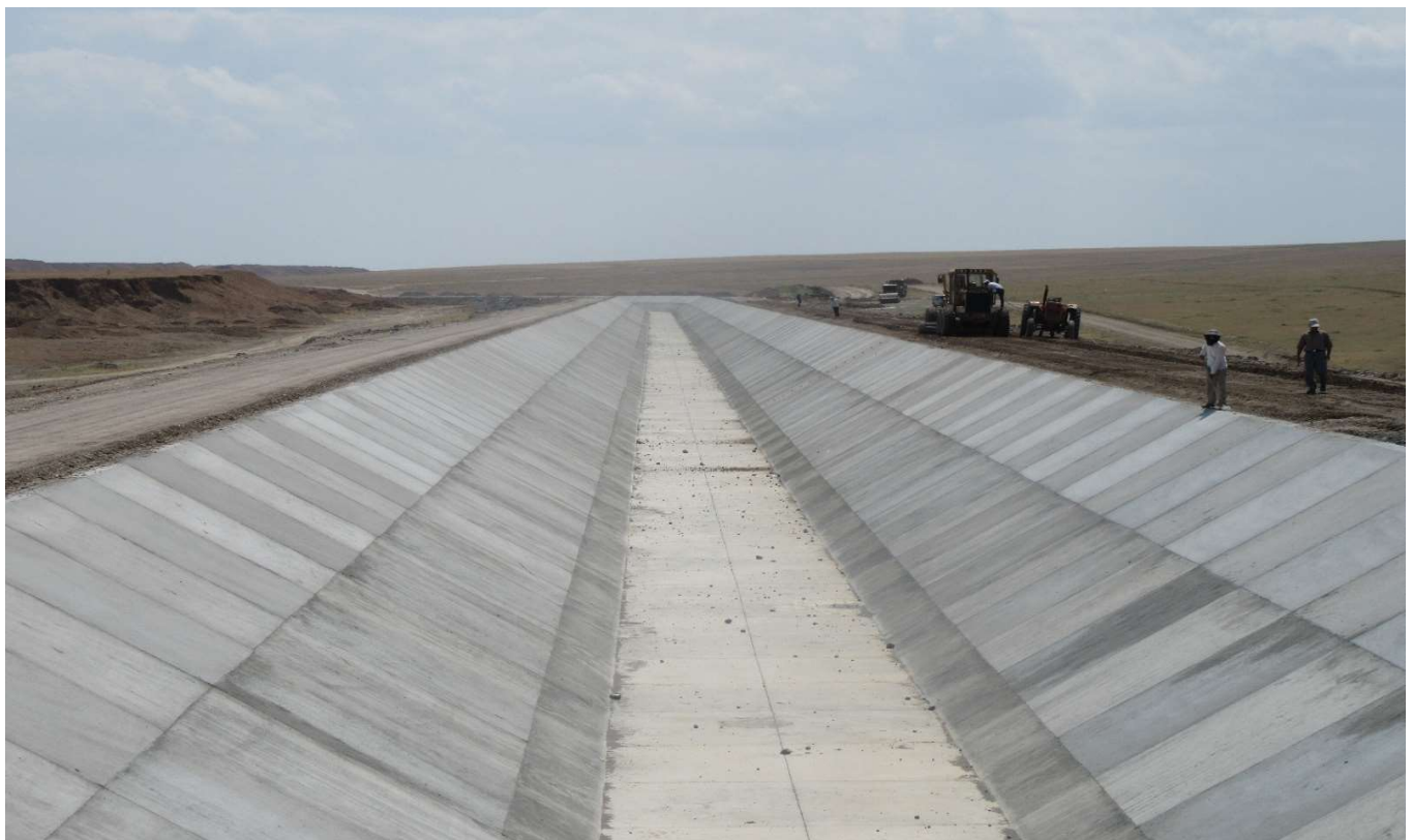
نمایی از کانال با پوشش لاینینگ بتنی
