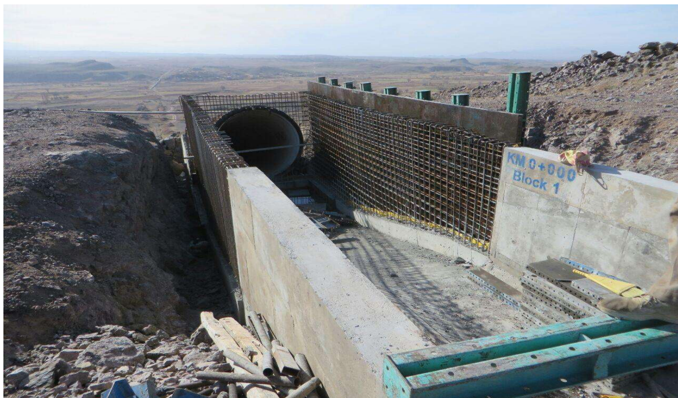
نمایی از اجرای سازه تبدیل خط لوله فولادی به قطر ۲۰۰۰ میلی‌متر به فلوم روباز
