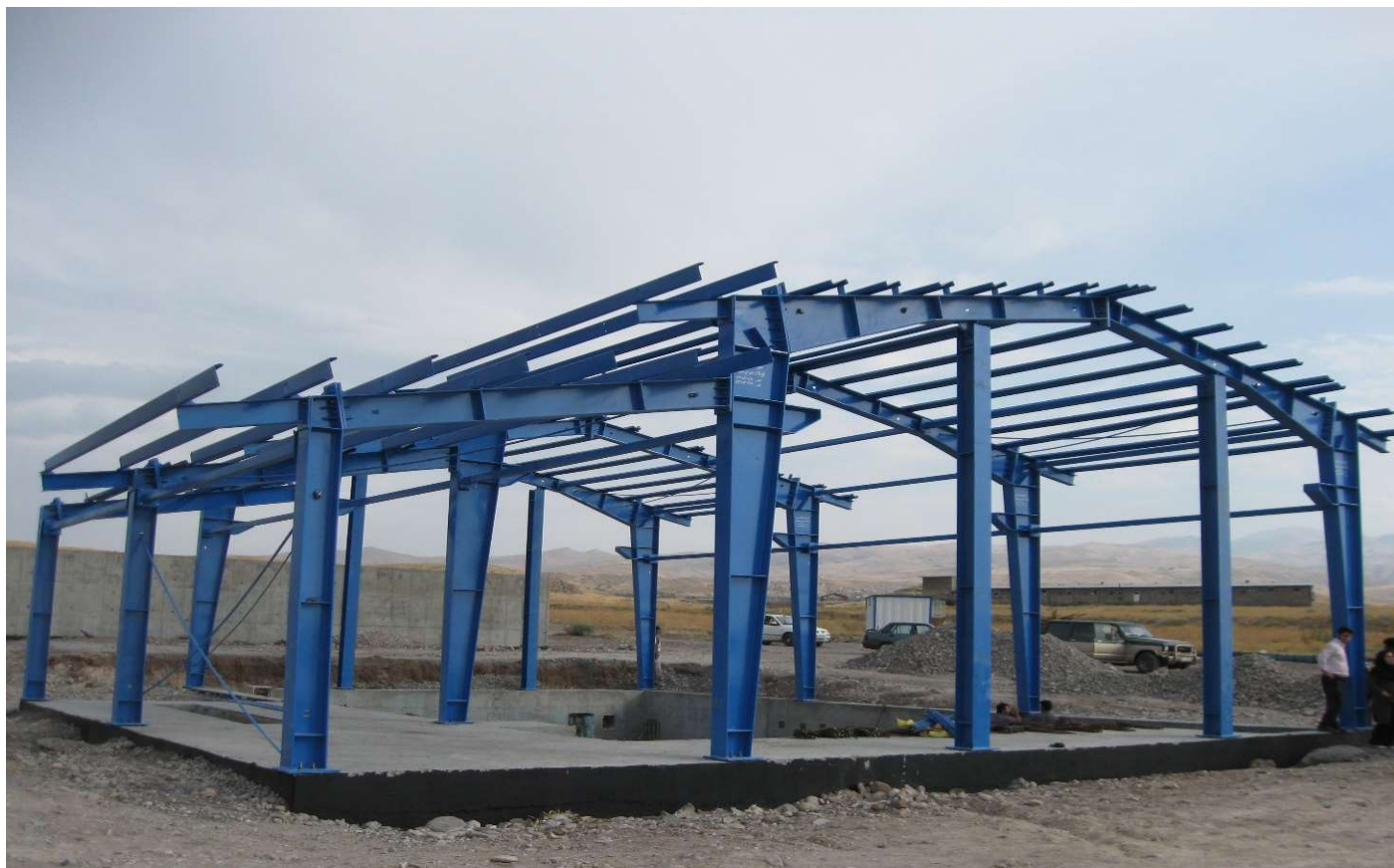
اجرای سازه ایستگاه پمپاژ
