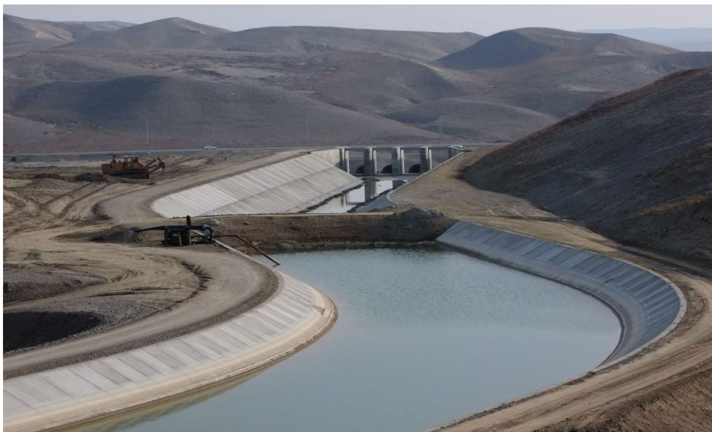
پروژه احداث کانال اصلی خداآفرین
