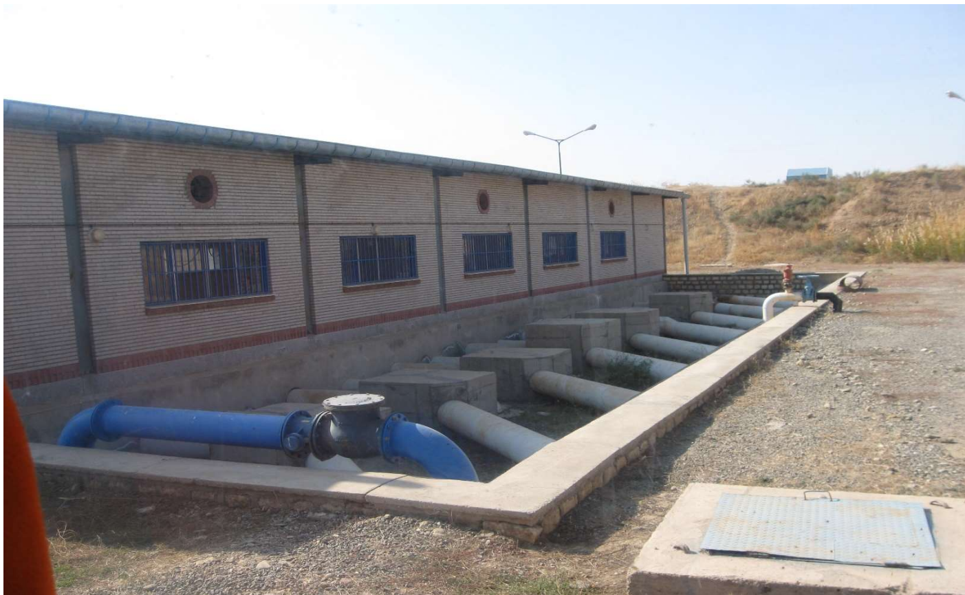
نمایی از ایستگاه پمپاژ اجرا شده
