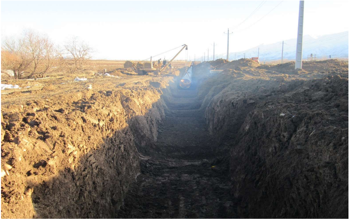
اجرای عملیات لوله‌گذاری فولادی
