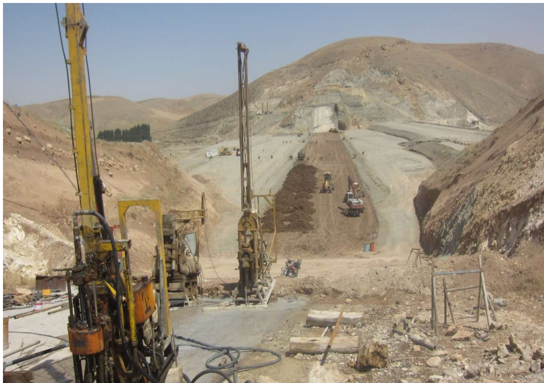
عملیات حفاری و تزریق بدنه سد
