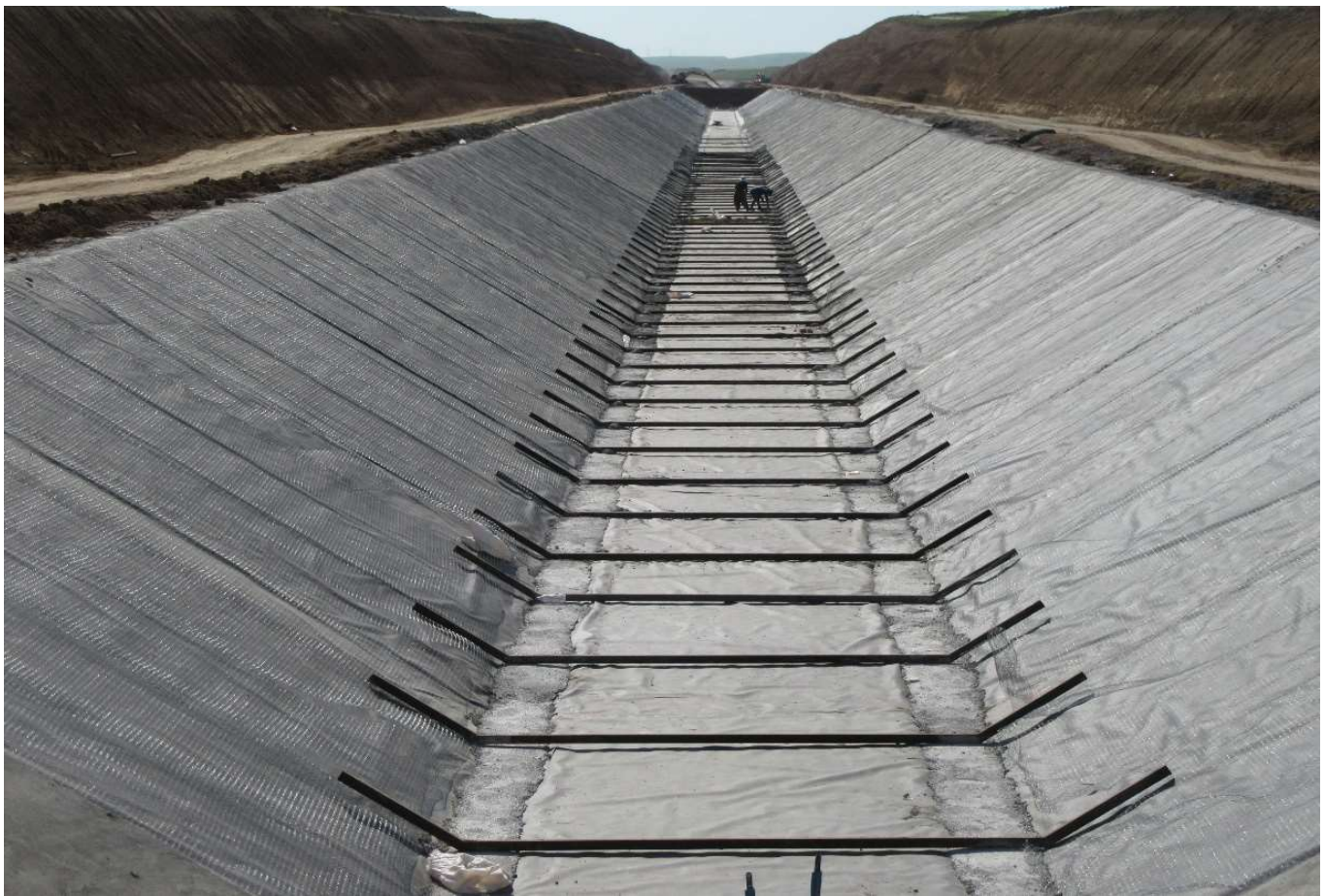
عملیات شابلون گذاری کف کانال جهت اجرای بتن ریزی لاینینگ
