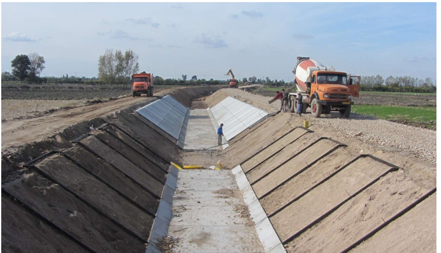
نمایی از اجرای لاینیگ کانال BMC بر روی بستر فیلترریزی شده
