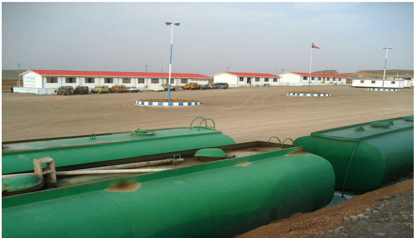
نمایی از محل تجهیز کارگاه
