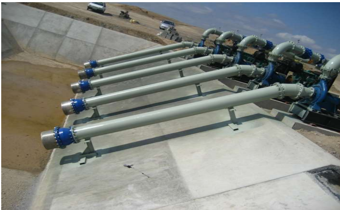
ایستگاه پمپاژ موقت خط غرقاب
