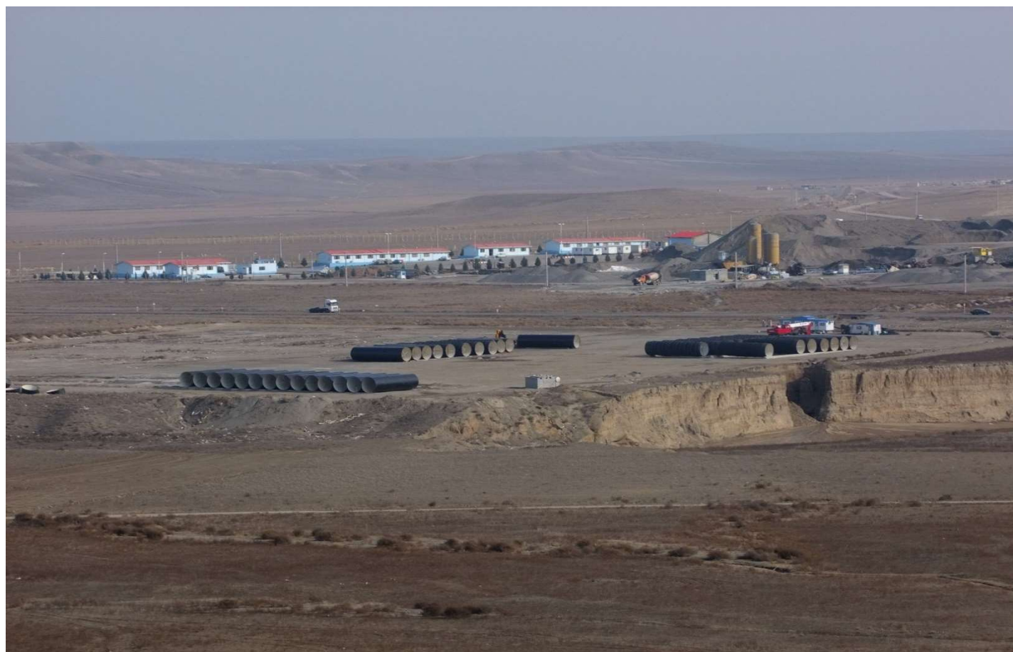
نمایی از محل تجهیز کارگاه
