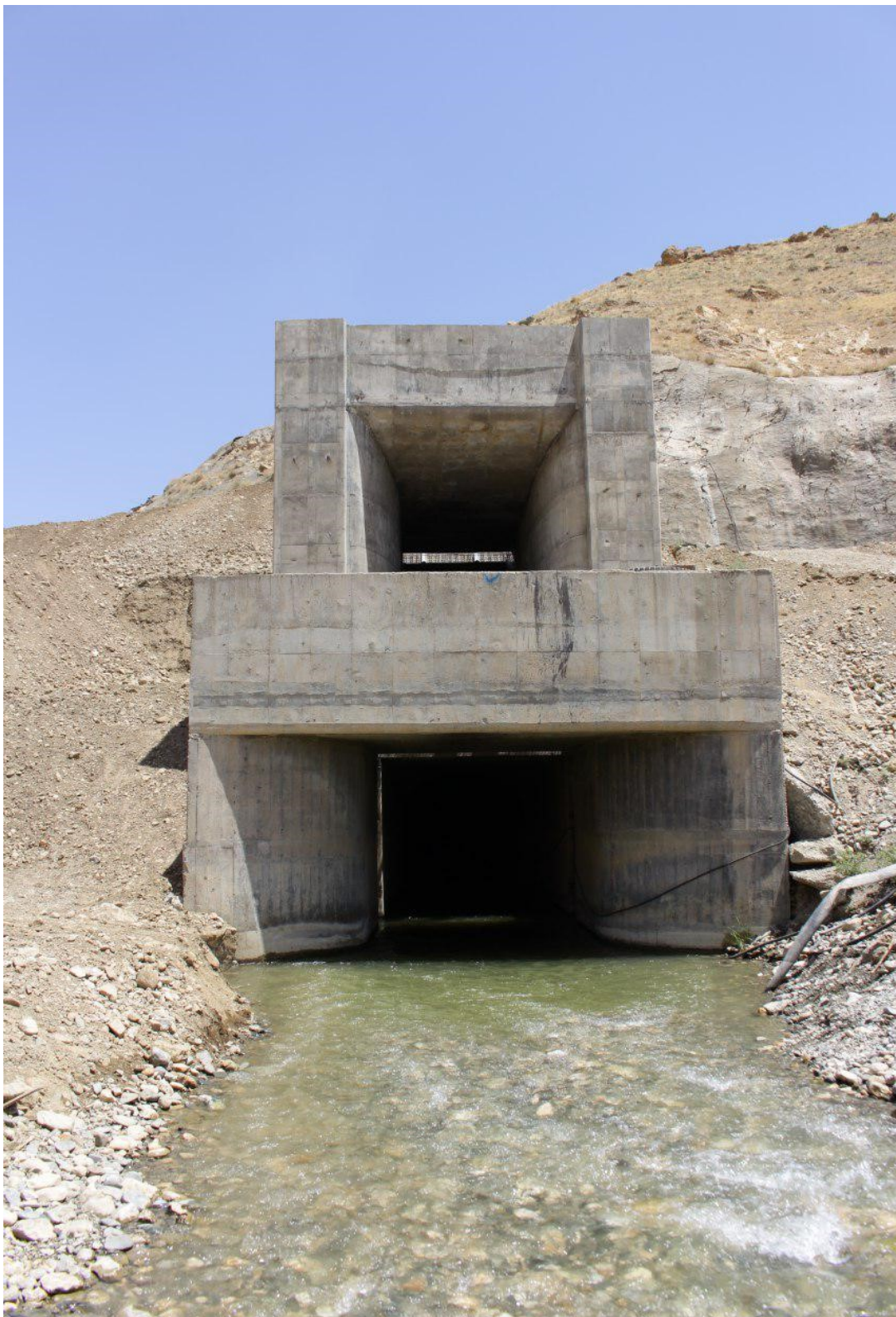
نمایی از سازه ورودی تونل
