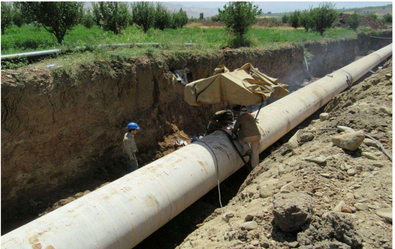
نمایی از عملیات جوشکاری لوله فولادی
