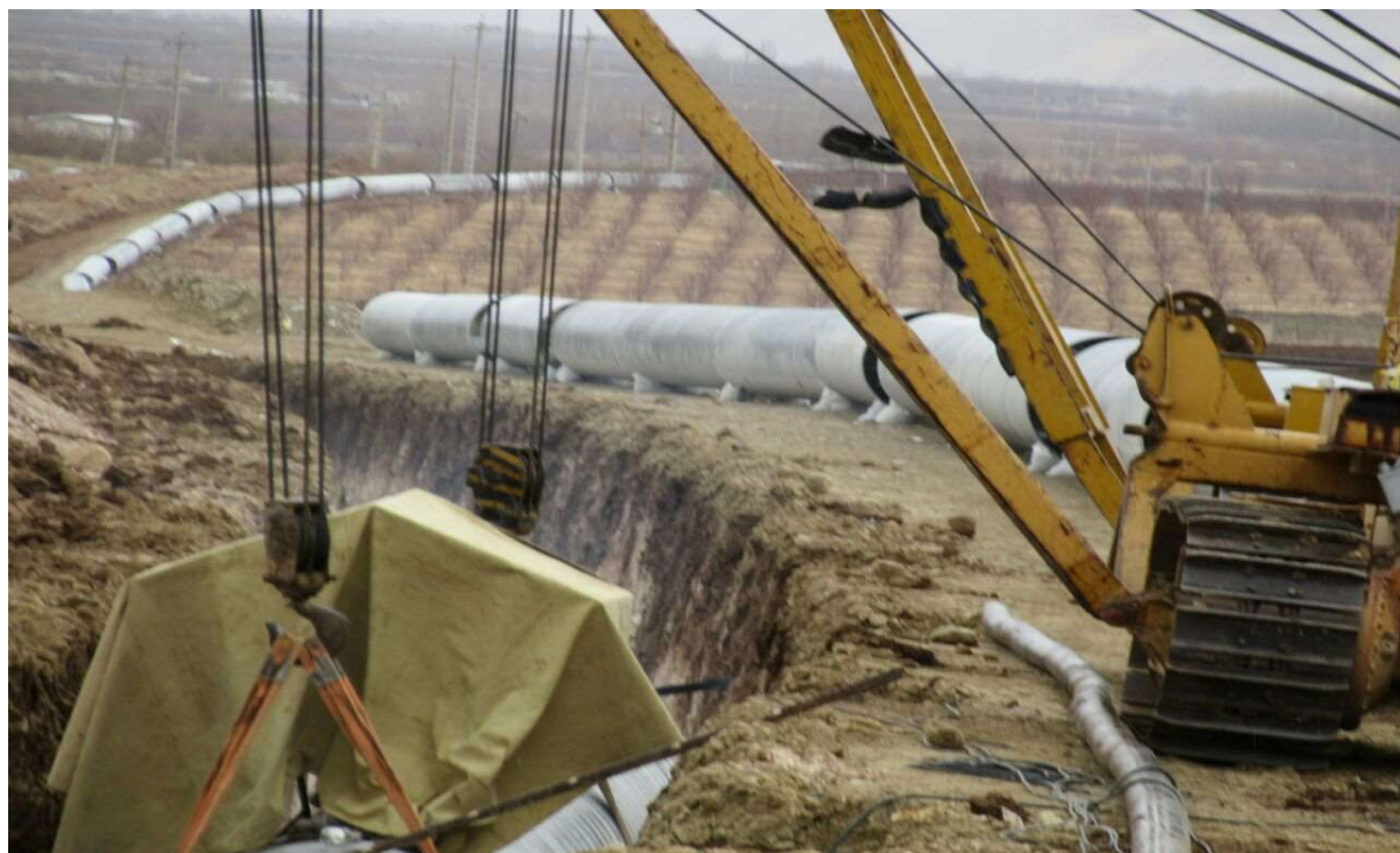
نمایی از عملیات لوله‌گذاری فولادی
