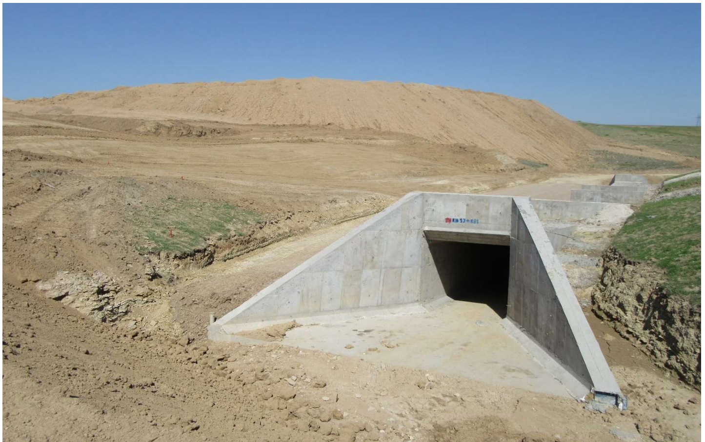
نمایی از کالورت اجرا شده
