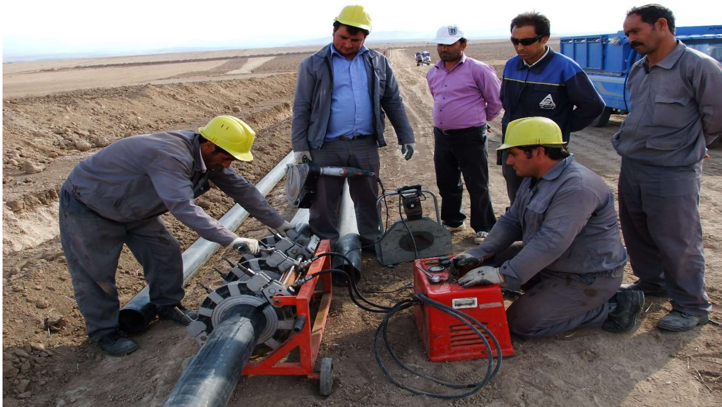
نمایی از عملیات لوله‌گذاری پلی اتیلن
