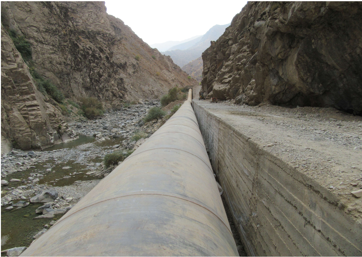
نمایی از اجرای عملیات تکمیلی لوله گذاری فولادی در محل احداث سیفون بادین
