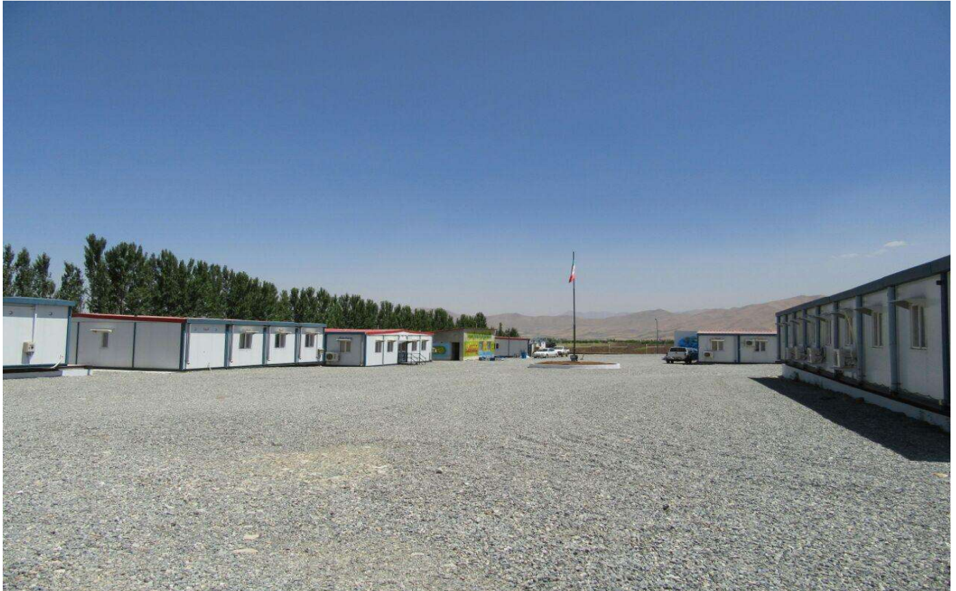
نمایی از تجهیز کارگاه
