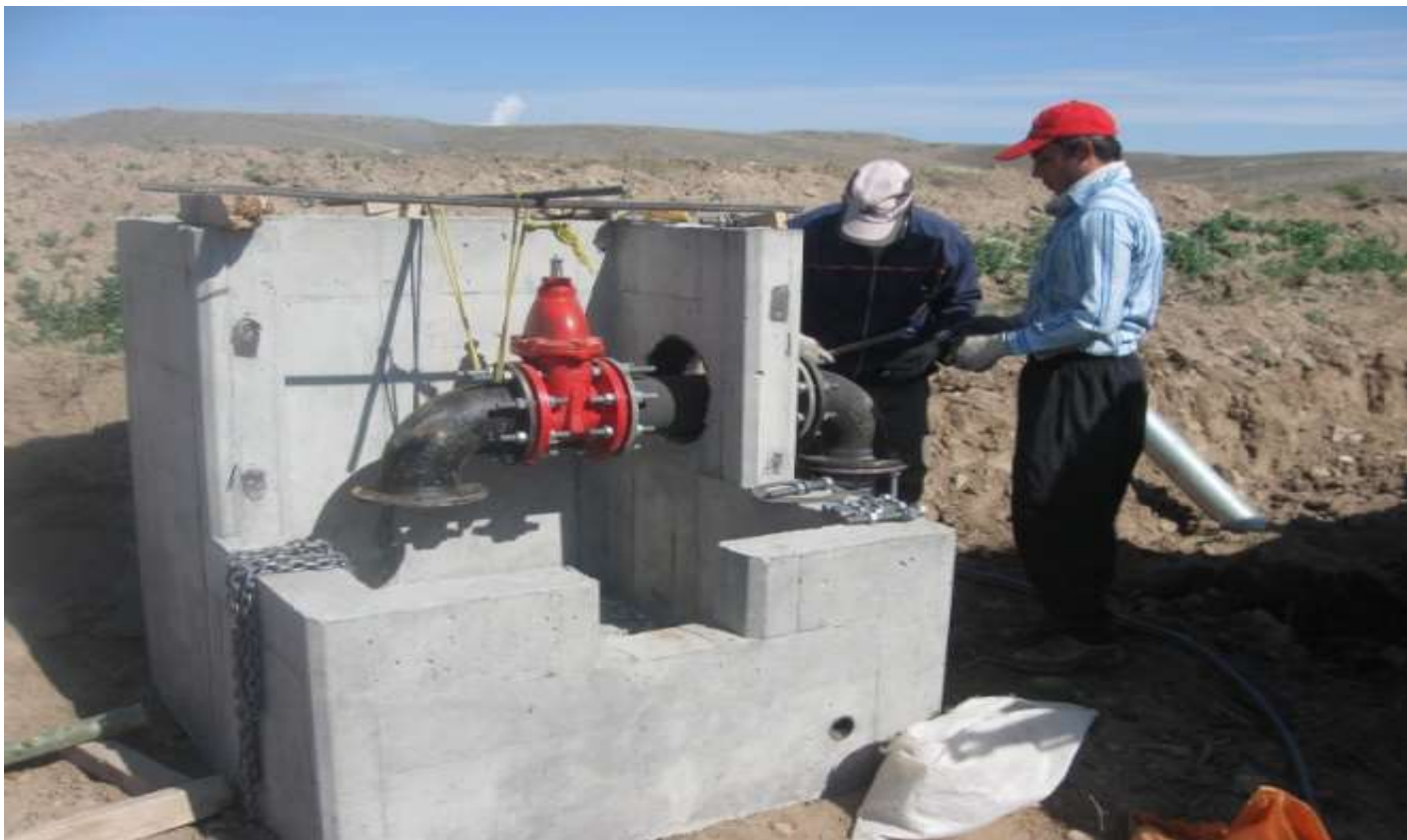
نصب اتصالات و متعلقات در محل حوضچه شیر
