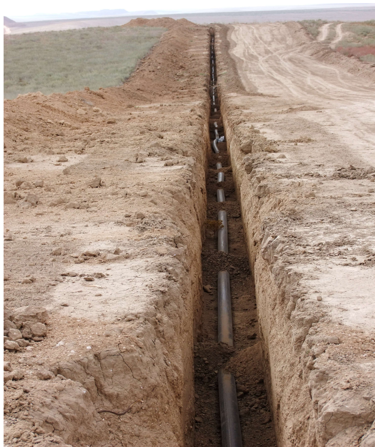
نمایی از مسیر لوله‌گذاری با لوله پلی اتیلن
