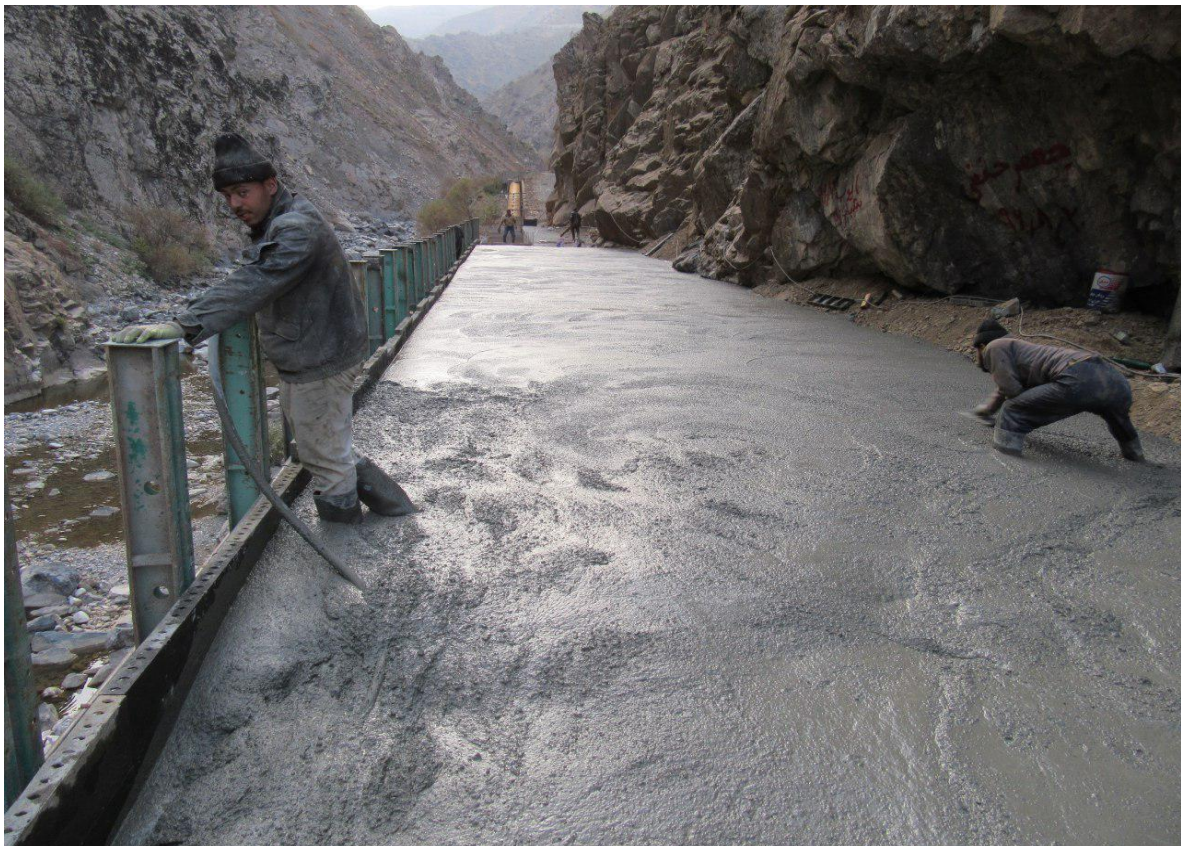
اجرای عملیات بتن ریزی جهت کیسینگ قسمتی از مسیر سیفون بادین
