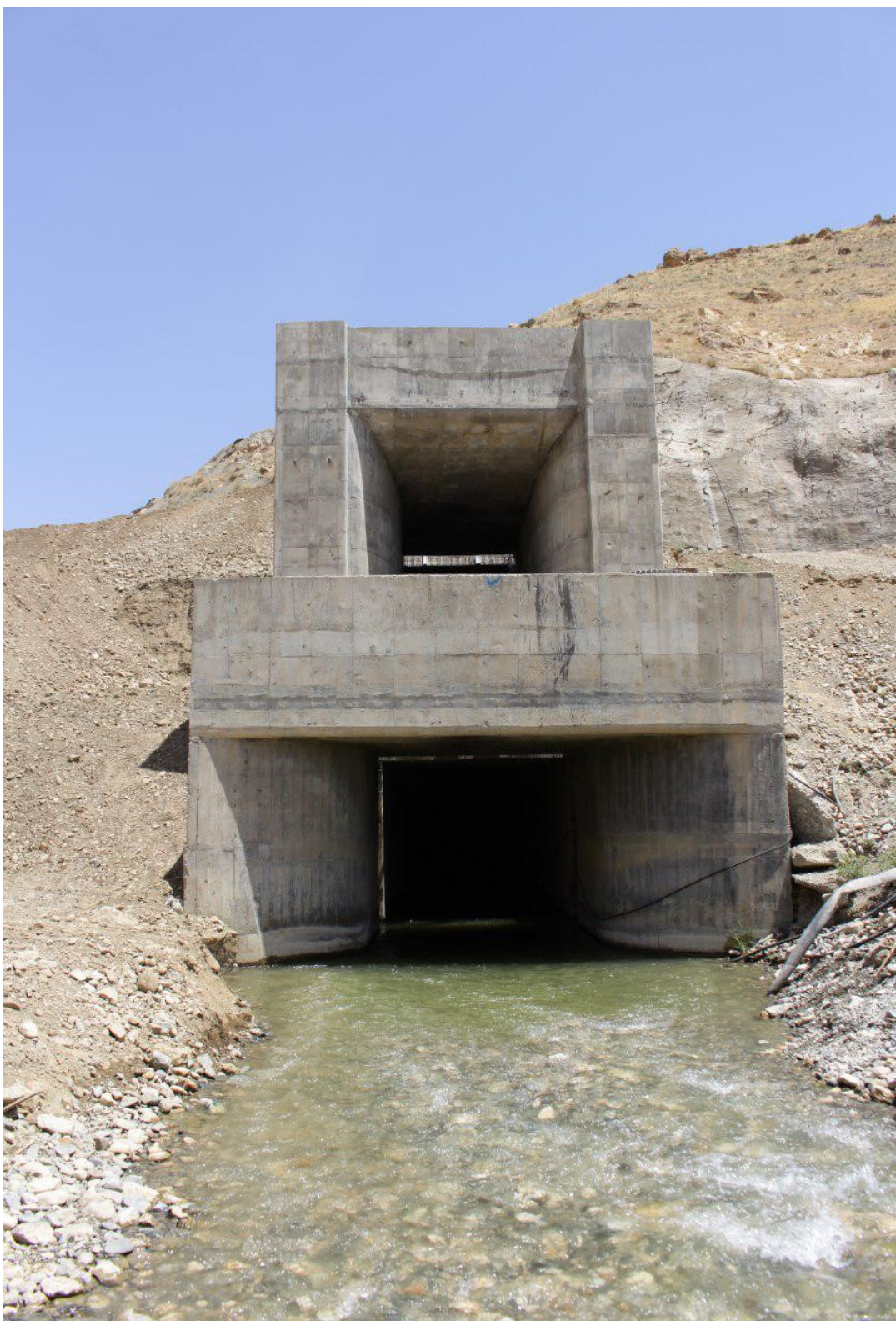
نمایی از سازه ورودی تونل
