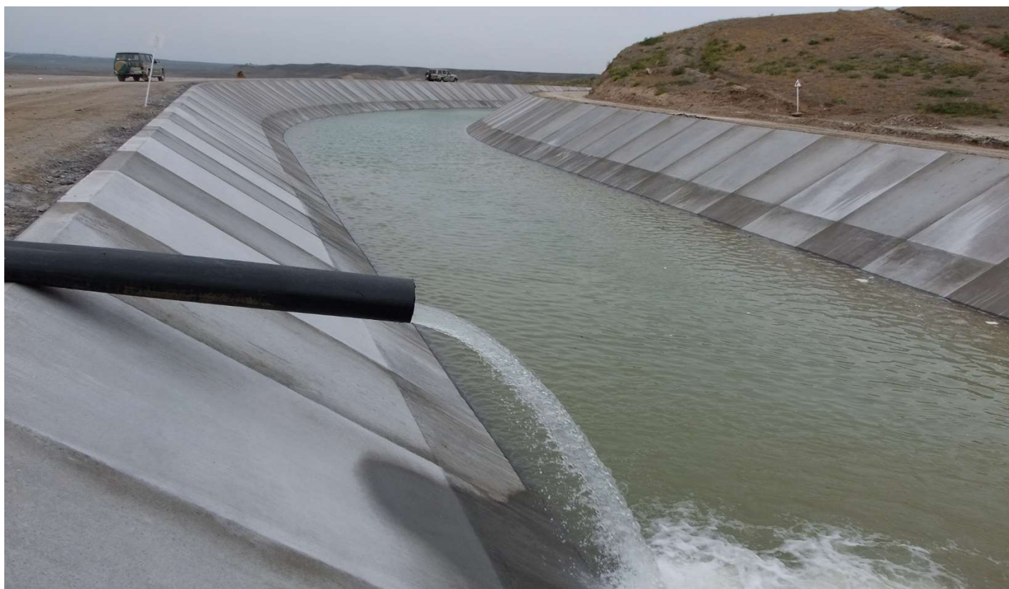
نمایی از آب‌اندازی کانال جهت بهره‌برداری آزمایشی
