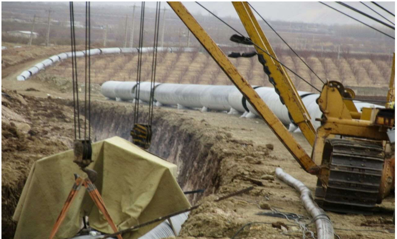
نمایی از عملیات لوله‌گذاری فولادی
