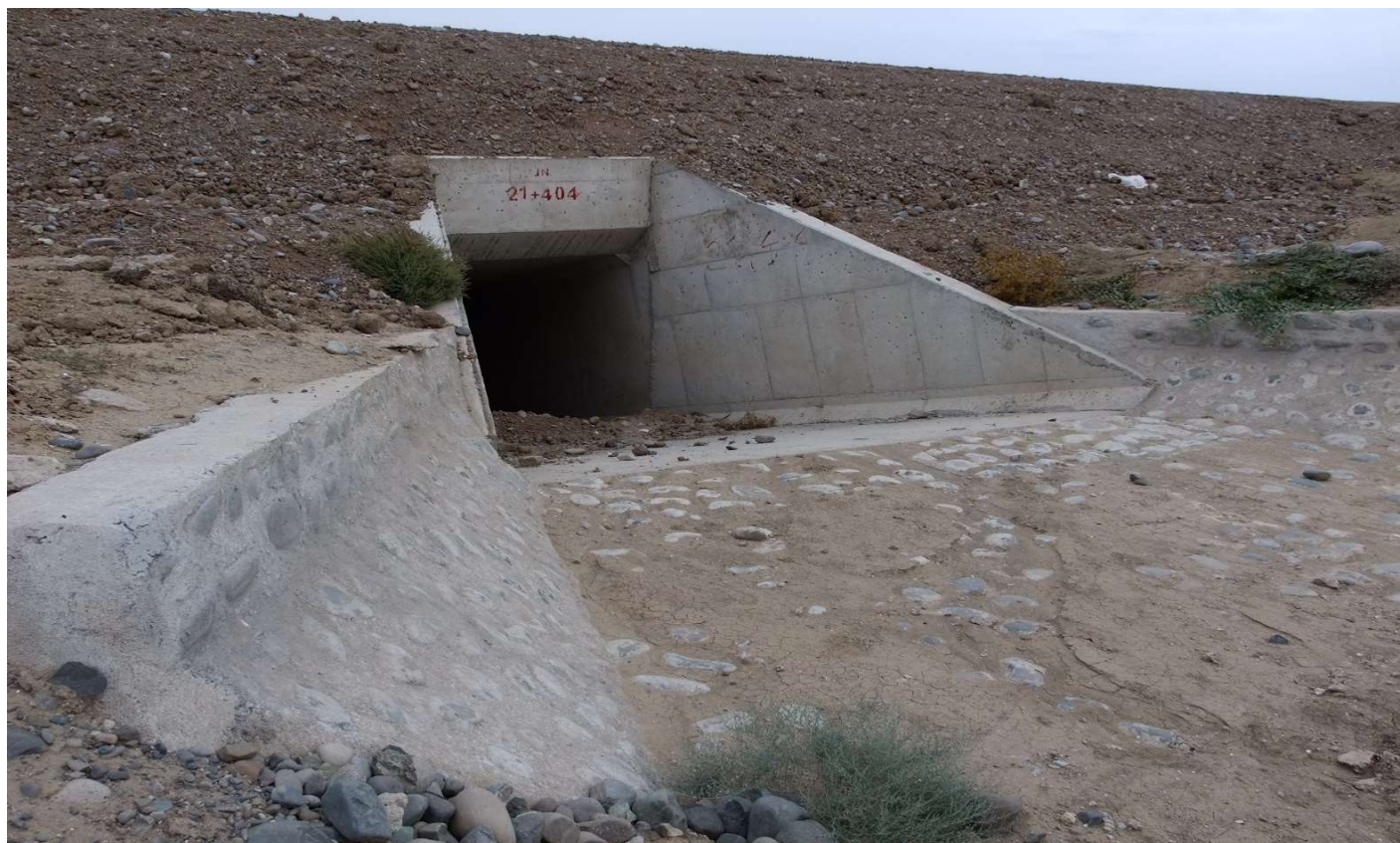
نمایی از سازه کالورت اجرا شده
