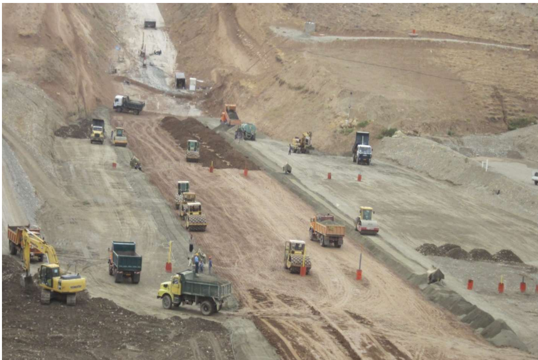
عملیات خاکریزی بدنه سد
