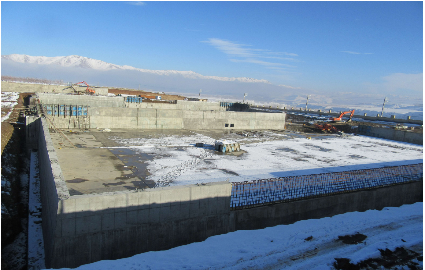
نمایی از حوضچه رزروار ایستگاه پمپاژ
