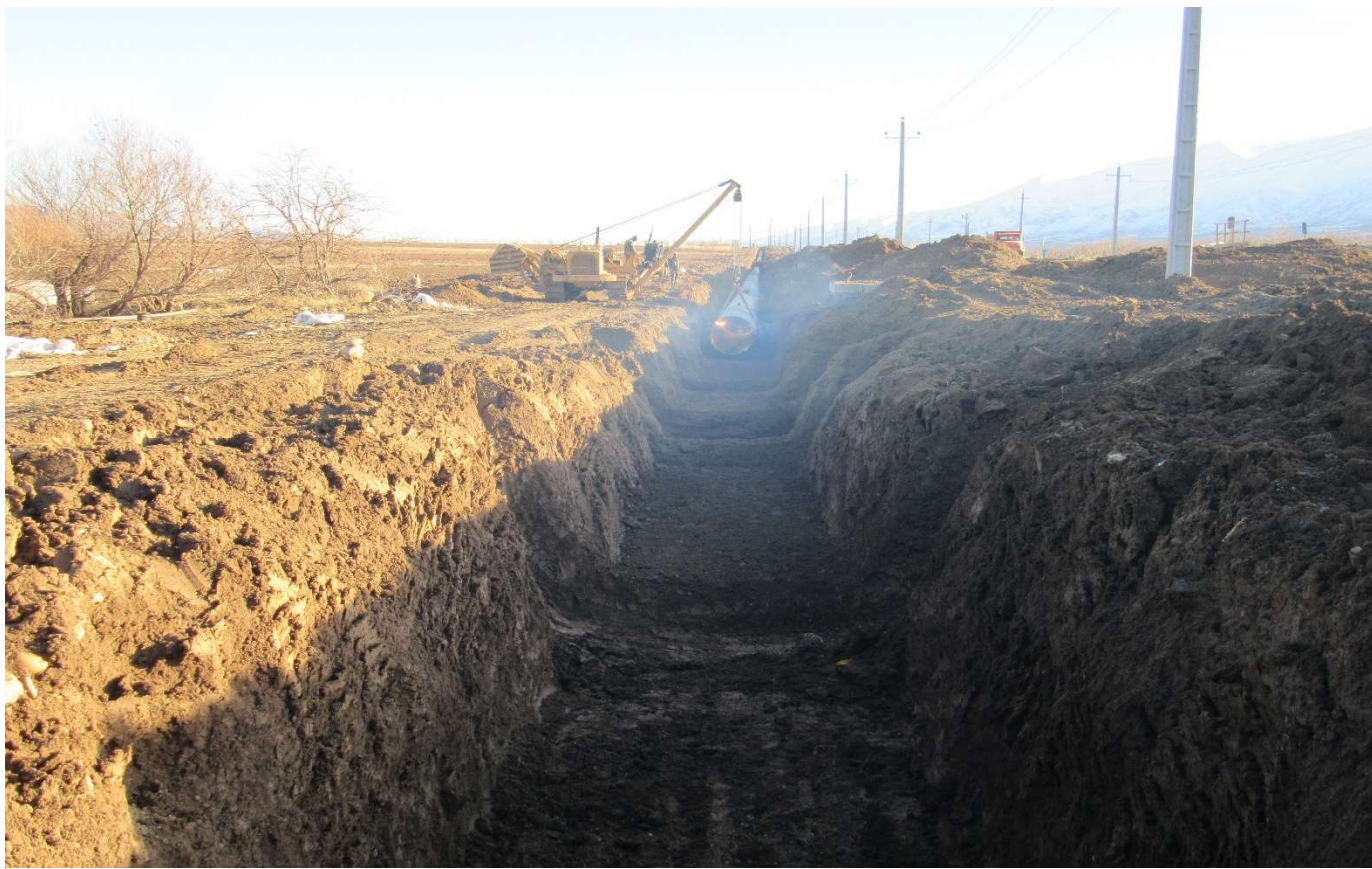
اجرای عملیات لوله‌گذاری فولادی
