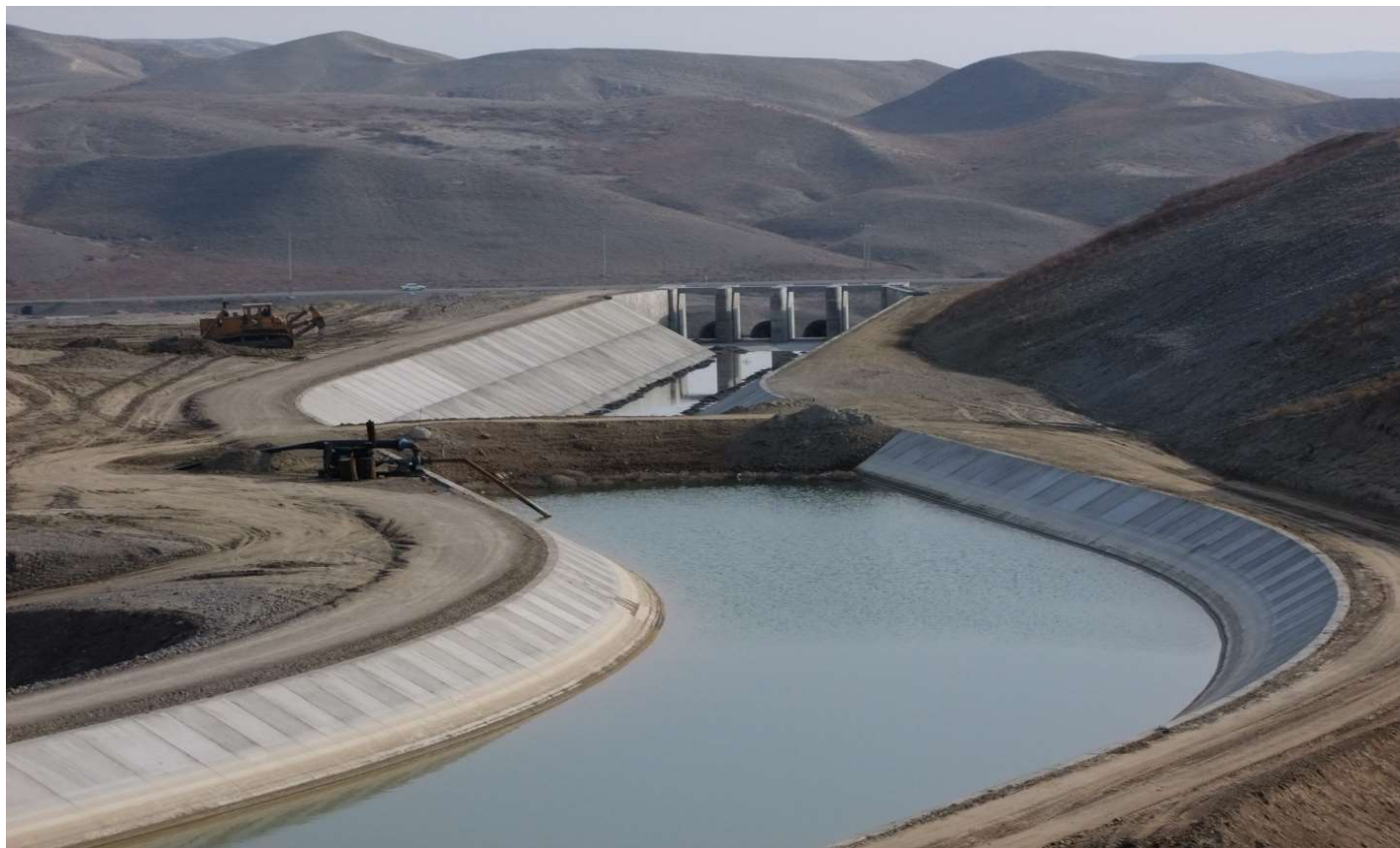
پروژه احداث کانال اصلی خداآفرین
