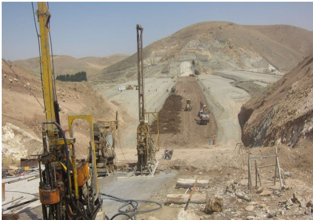
عملیات حفاری و تزریق بدنه سد
