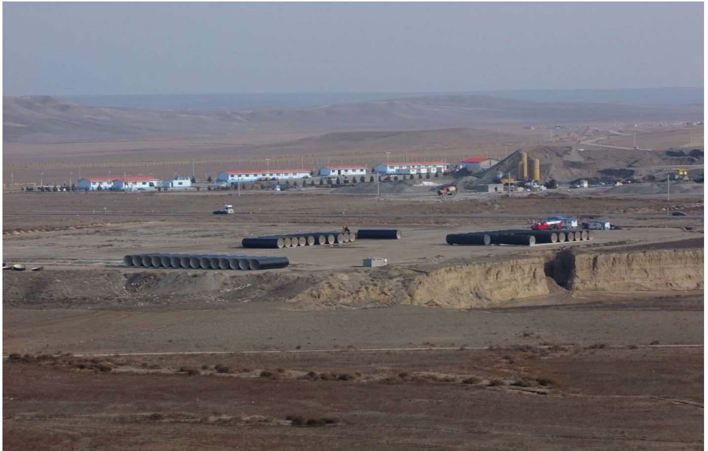
نمایی از محل تجهیز کارگاه
