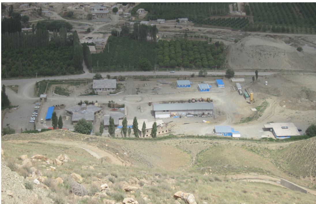
نمایی از محل تجهیز کارگاه
