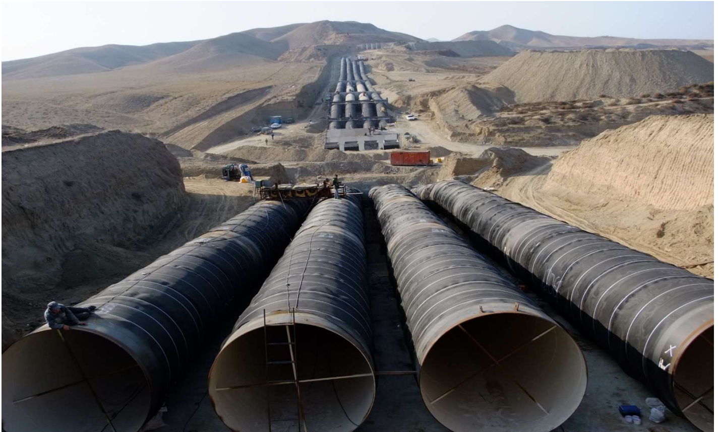
اجرای سیفون قوری چای با لوله فلزی به قطر ۳۰۰۰ میلی متر
