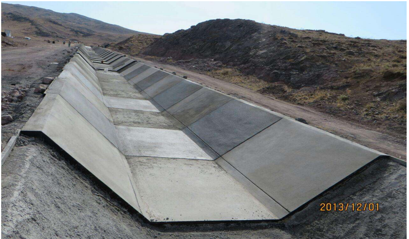
نمایی از اجرای کانال دوزنقه‌ای با پوشش بتنی
