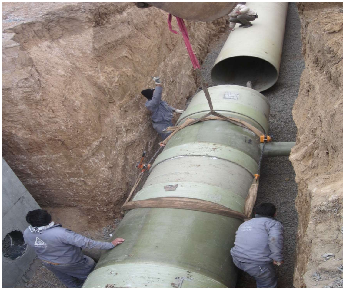
نمایی از لوله‌گذاری با لوله GRP
