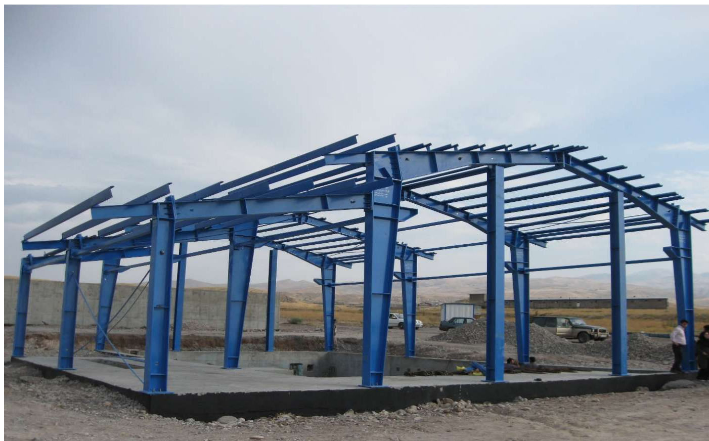
اجرای سازه ایستگاه پمپاژ
