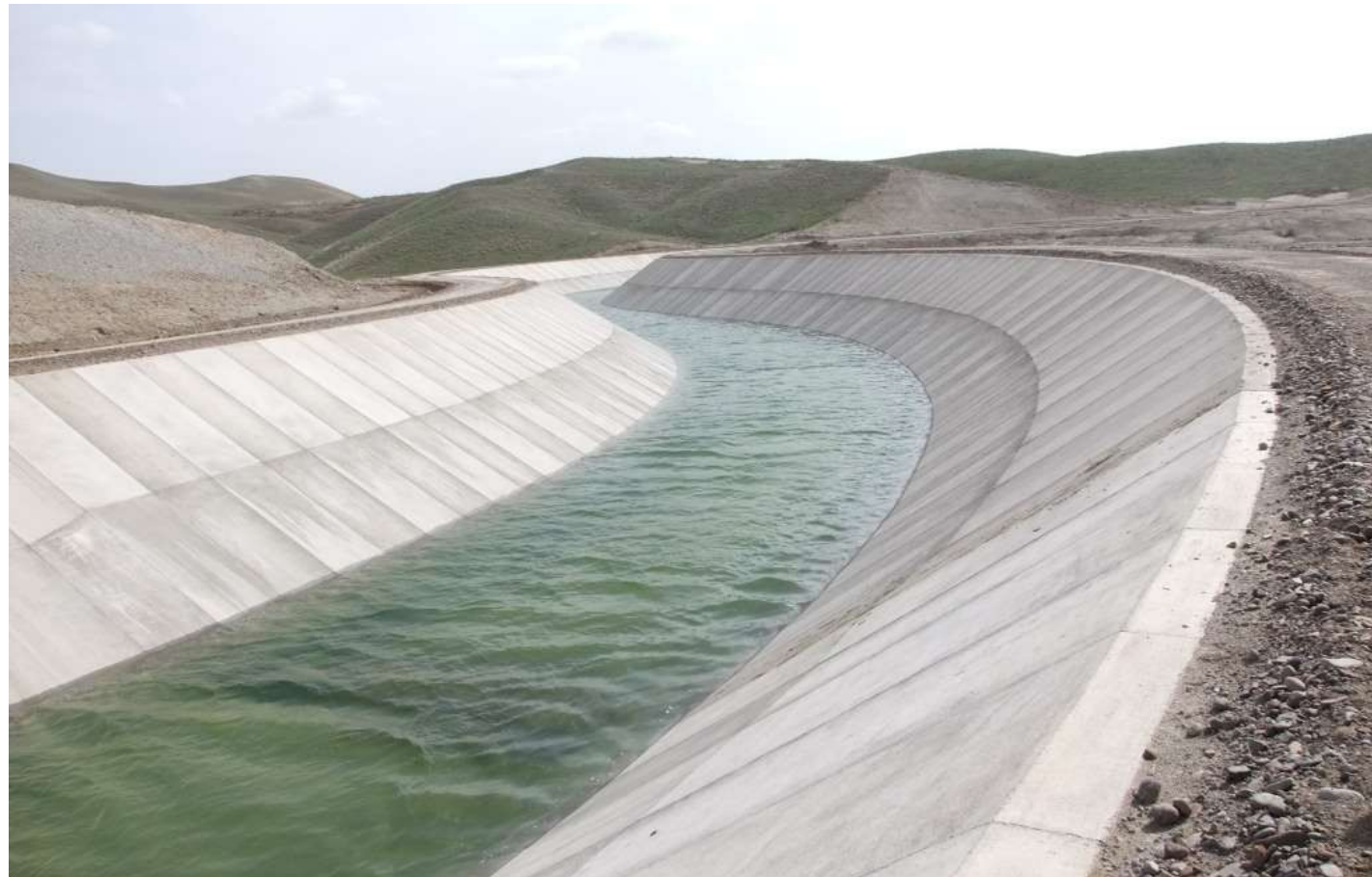
نمایی از کانال اجرا شده پس از آب‌اندازی جهت بهره‌برداری آزمایشی
