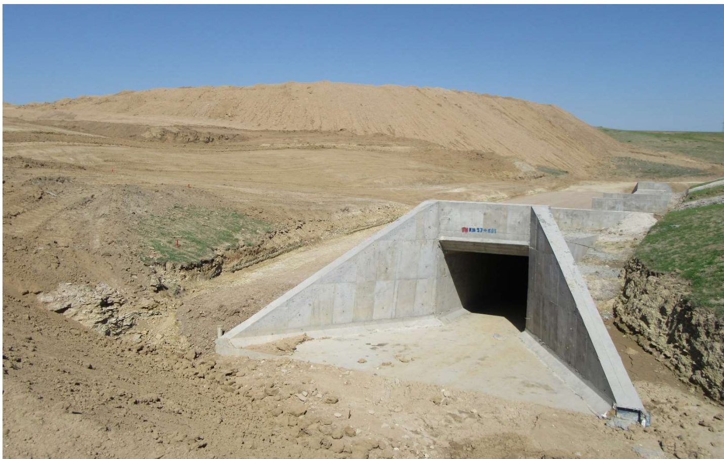
نمایی از کالورت اجرا شده
