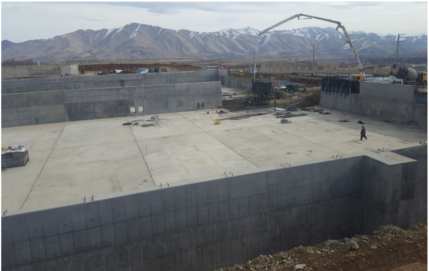
نمایی از حوضچه رزروار ایستگاه پمپاژ
