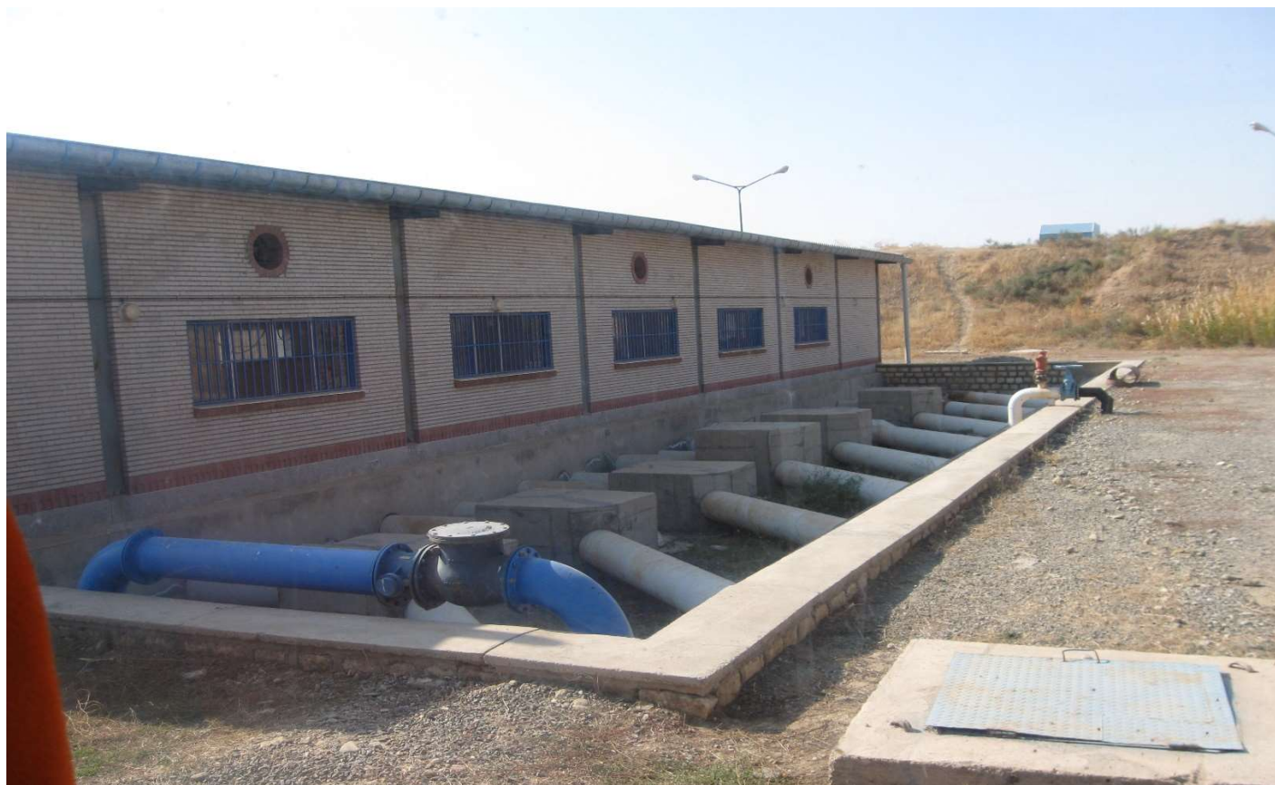
نمایی از ایستگاه پمپاژ اجرا شده
