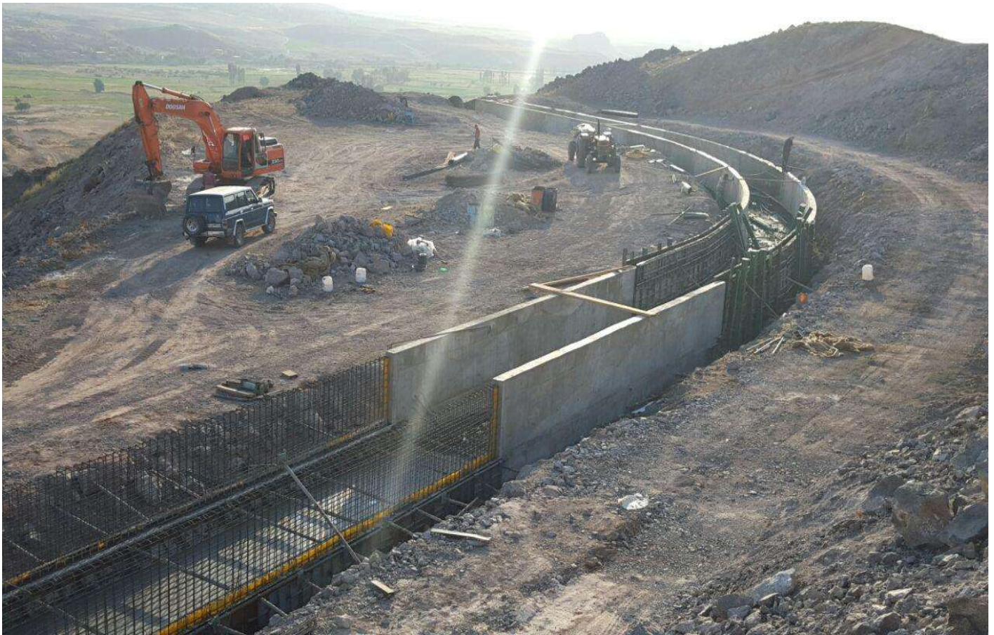
نمایی از اجرای فلوم به صورت روباز
