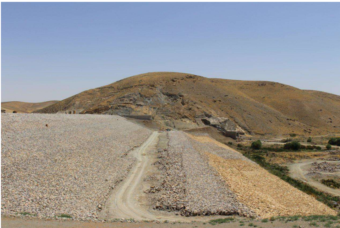
نمایی از عملیات ریپ رپ بالادست
