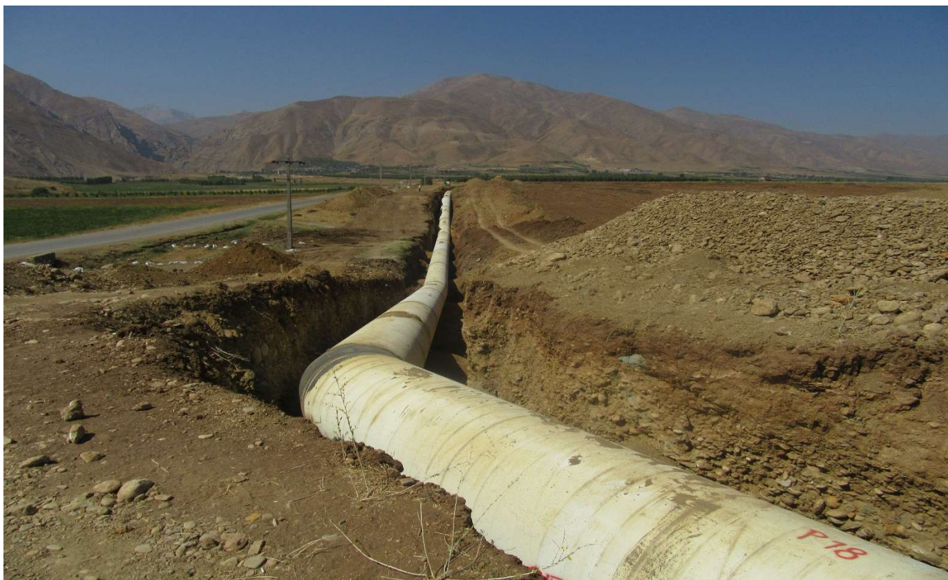
اجرای عملیات لوله‌گذاری فولادی
