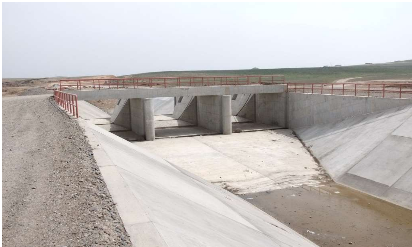
نمایی از سازه دو منظوره تنظیمی آمیل و پل ماشین‌رو
