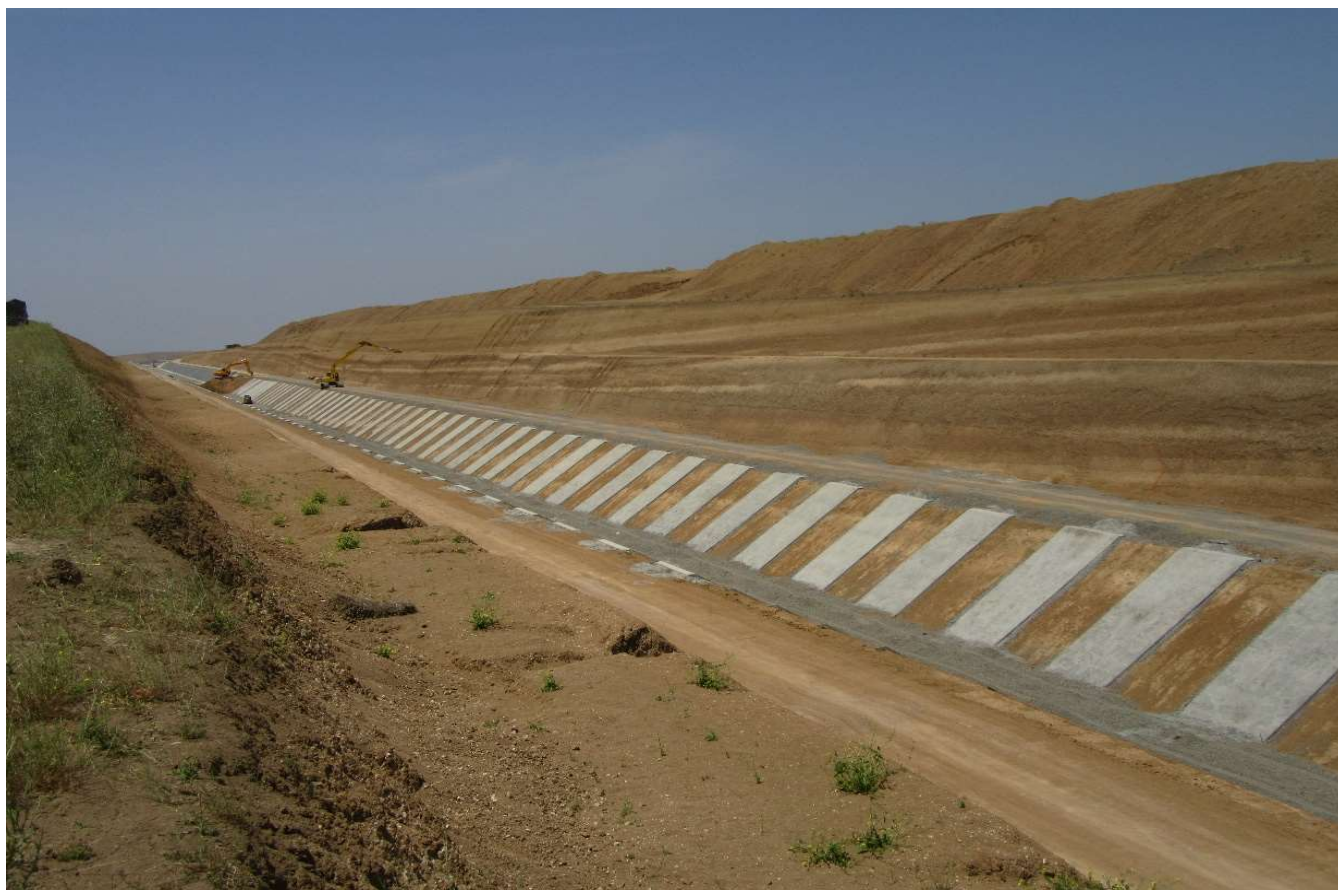
عملیات زیرسازی لاینینگ کانال
