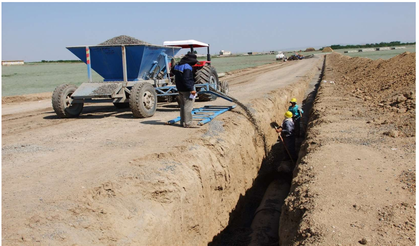
نمایی از فیلترریزی دور لوله GRP با استفاده از مصالح رودخانه‌ای دانه‌بندی شده
