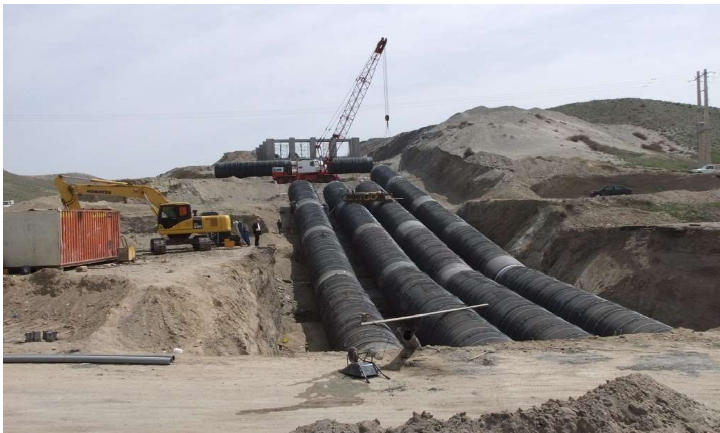
مراحل اجرای عملیات لوله‌گذاری سیفون قوری چای
