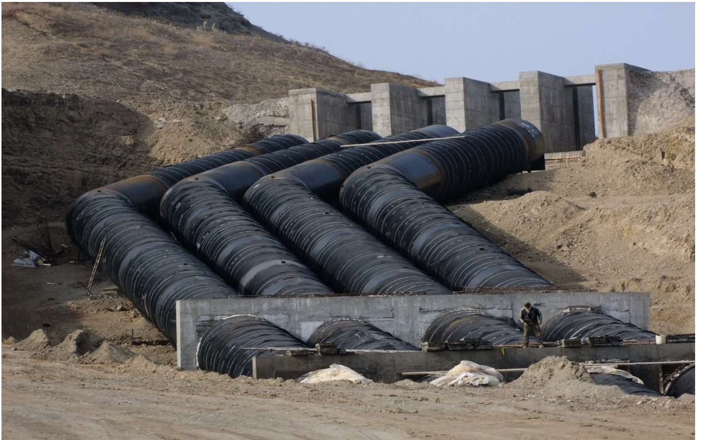
نمایی از محل سازه ترانزیشن خروجی سیفون قوری چای (تبدیل مقطع دایره به باکس)
